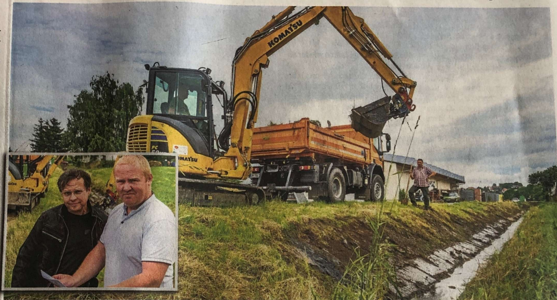
Der Gewässerunterhaltungsverband Obere Unstrut/Notter arbeitet mit einem der drei Trupps gerade an einem Bach in Felchta, der vor gut einem Jahr nach einem Starkregen überflutet wurde. Nun wird das zugewachsene Flussbett wieder freigelegt. Kleines Bild: Verbandsingenieur Björn Goldmann und Geschäftsführer Carsten Müller (rechts) vom GUV Obere Unstrut/Notter.
